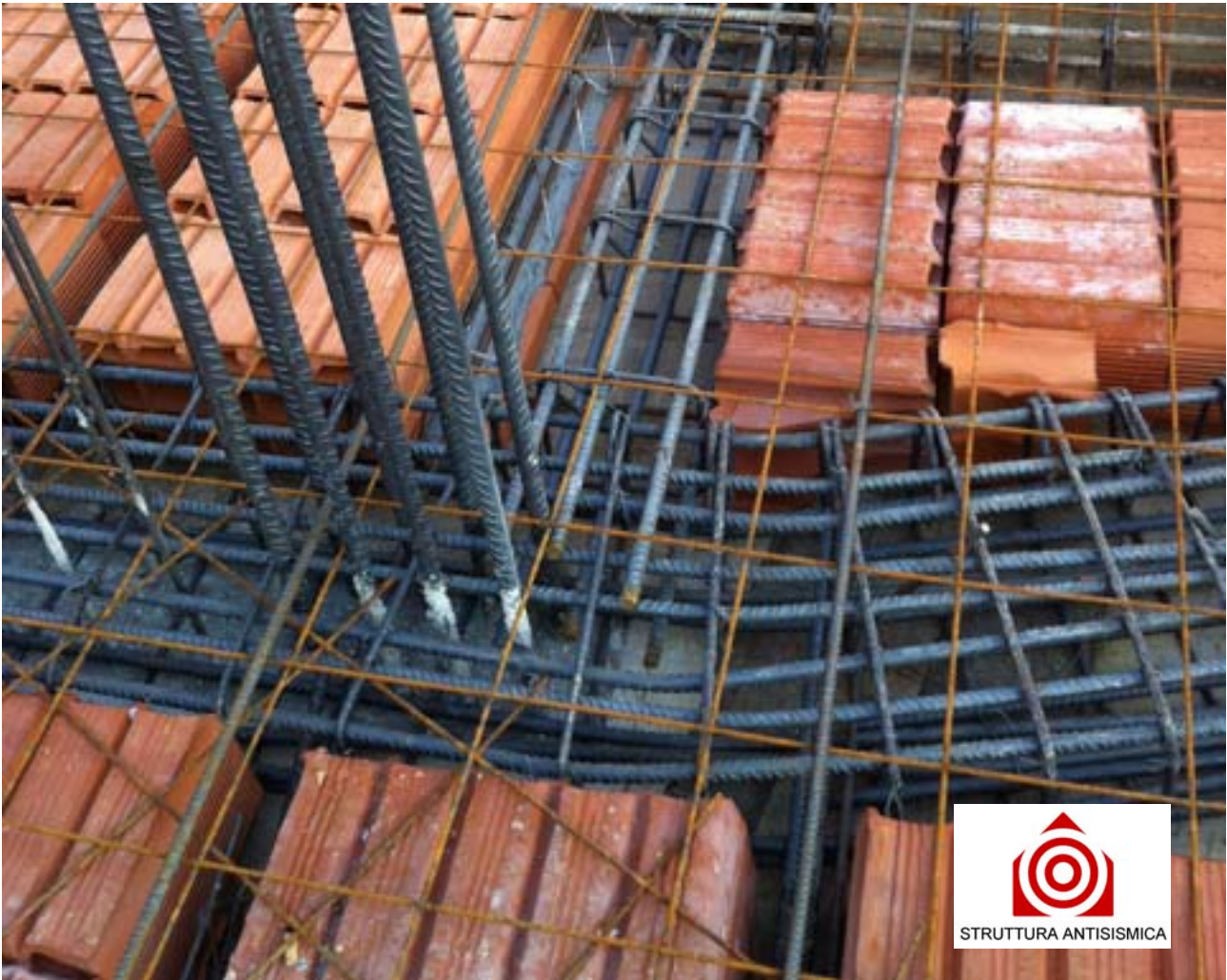
Particolare nodo strutturale antisismico
